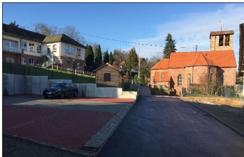
Im Vordergrund sind die neu errichteten Parkplätze zu sehen, dahinter der Geräteschuppen mit barrierefreien Wegen.
