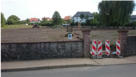
Die Bauarbeiten haben begonnen. Nach den Planierarbeiten werden nun bereits die neuen Wege angelegt. © Stadt Osterburken
