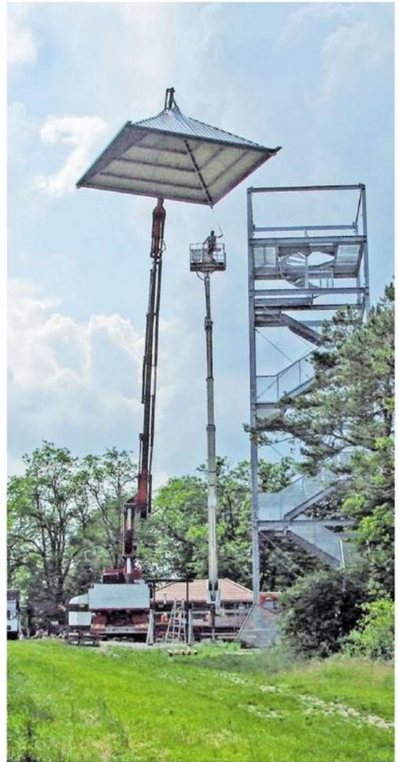
Das Dach wurde nun dem neuen Aussichtsturm auf dem Uissigheimer Stahlberg aufgesetzt.
