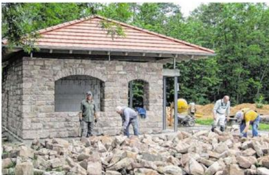
Die Schutzhütte erhält eine Verkleidung aus Sandsteinmauerwerk. Uissigheimer Bürger packen dabei kräftig mit an.
