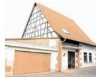
Das bestehende Gemeindehaus wird abgerissen.
