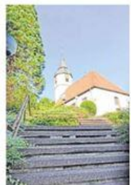
Der bislang einzige Weg zur Kirche. Jetzt ist ein barrierefreier Aufgang geplant.
