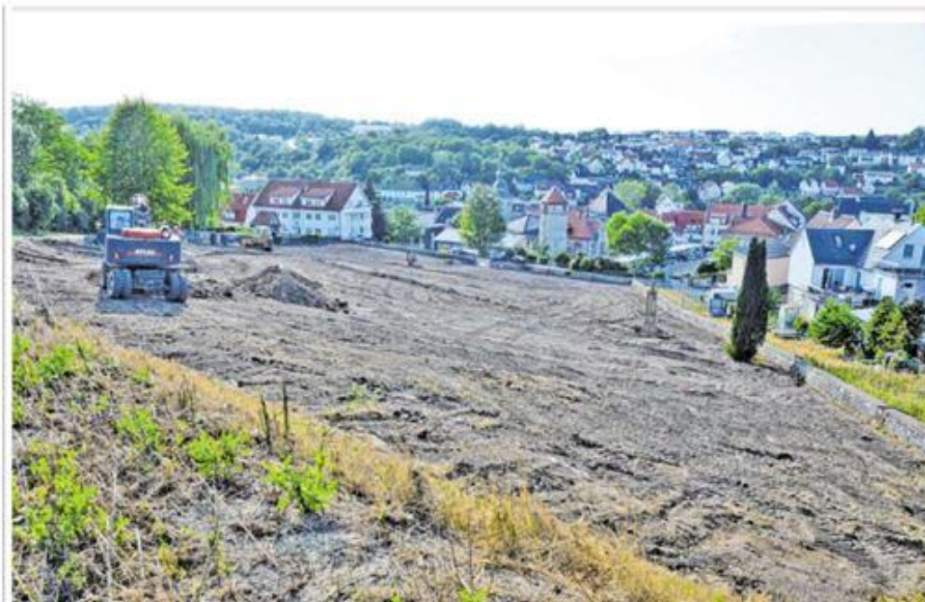
Im Ganzen sind seit geraumer Zeit die Weesebauarbeiten auf dem Areal des „Alten Friedhofs“ in Osterburken. Im Herbst soll gepflanzt werden.
