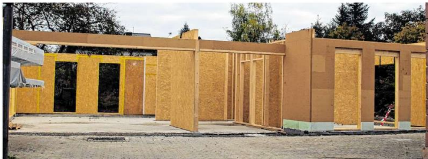
Die Wände in Holzständerbauweise sind beim neuen evangelischen Gemeindehaus in Großeicholzheim schon zu sehen.
