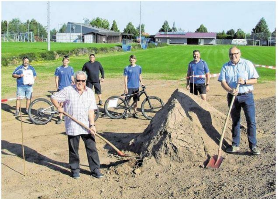
Nachdem der Vorsitzende der Leader-Gebietskulisse Badisch-Franken, Alfred Beetz (links) und Kilsheims Bürgermeister Thomas Schreglmann im Beisein der FC-Mitglieder zum Spaten gegriffen hatten, können nun die Bauarbeiten für den Bikepark auf dem Sportgelände des FC Hundheim/Steinbach starten. BILD: HANS-PETER WAGNER
