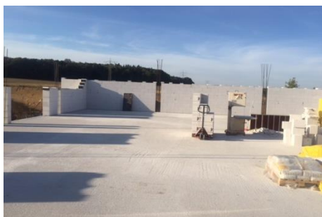
Baufortschritt der barrierefreien Tanzschule in Adelsheim
