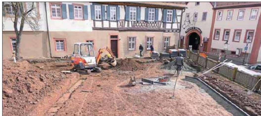
Noch laufen die Erdarbeiten, doch ab Mai soll das vordere Drittel des neuen Biergartens des Gasthauses „Zum Schwanen“ Sitzplätze für ca. 70 Besucher bieten. Foto: Andreas Hanel
