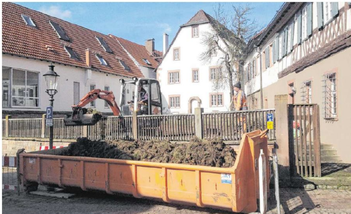
Die Firma Tomac aus Buchen hat auf der Trunzerwiese mit der Errichtung des Kultur-Biergartens begonnen.
