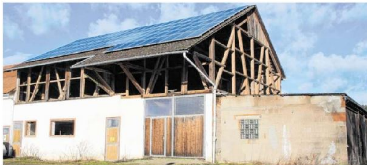
Der Bauausschuss des Rosenberger Gemeinderats hatte keine Einwände gegen den Änderungsantrag zum Umbau eines Stallgebäudes zur „Kirchenkäserei“ in Sindolsheim.
